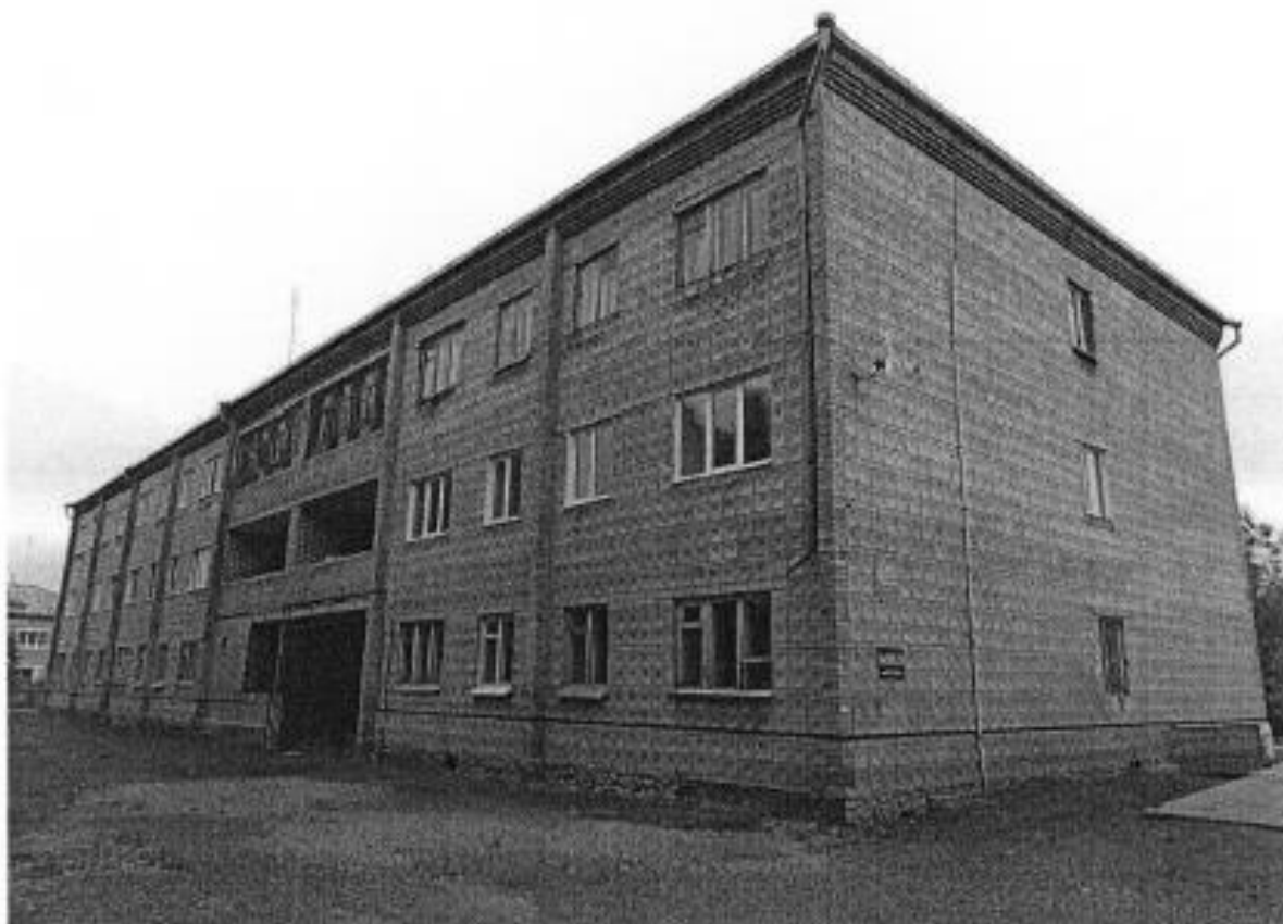
Рис. 1. Фото фасада больницы до ремонта
