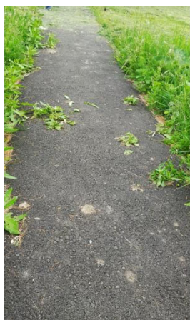
Вид тротуара в 2023 году после ремонта 2022 года (трава растет сквозь основание и а/б толщиной 7 см)
